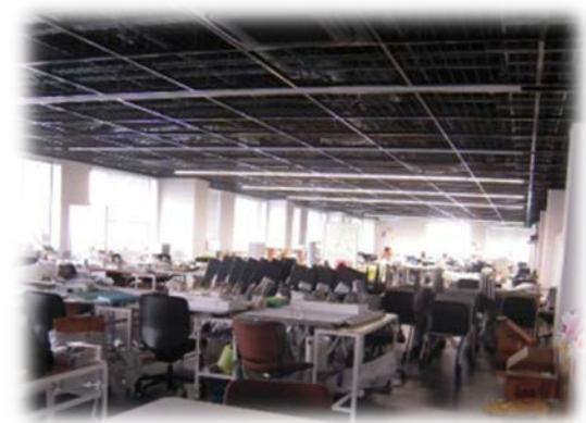
ワンルーム化 (全学年 共通 製図室)
