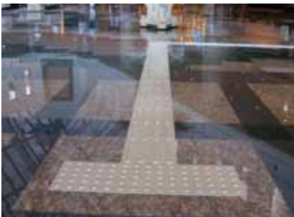
ホテルのグレード感を考慮した誘導ブロックの敷設
