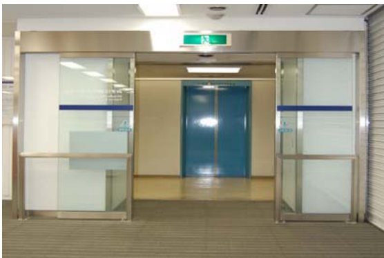
入口の段差解消と自動ドアの設置
