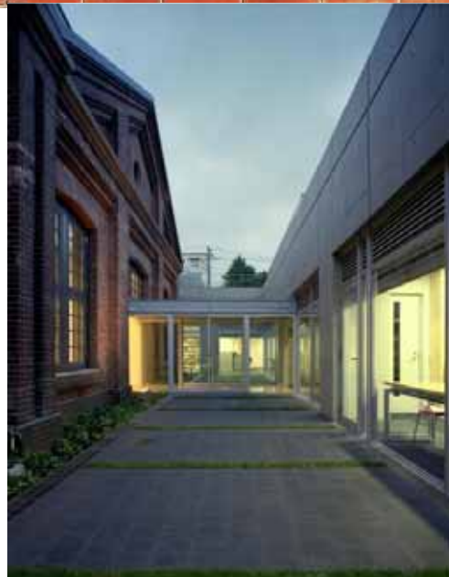
中庭 赤レンガ倉庫と新しい建物の融合が良く解る
