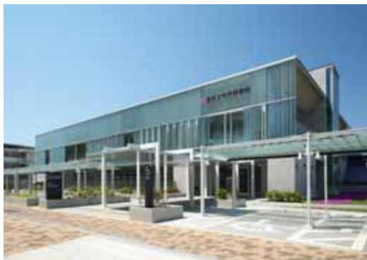
建物全景 住宅側は半透明のプロフィリットガラススクリーンで光のみ取り入れる構造。住宅との目線をさえぎる効果がある。
