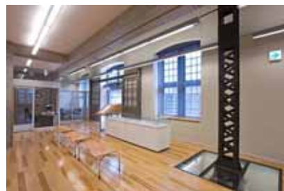
ラチス柱と基礎を保存展示
