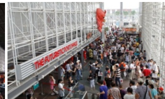
単管格子による広場空間
