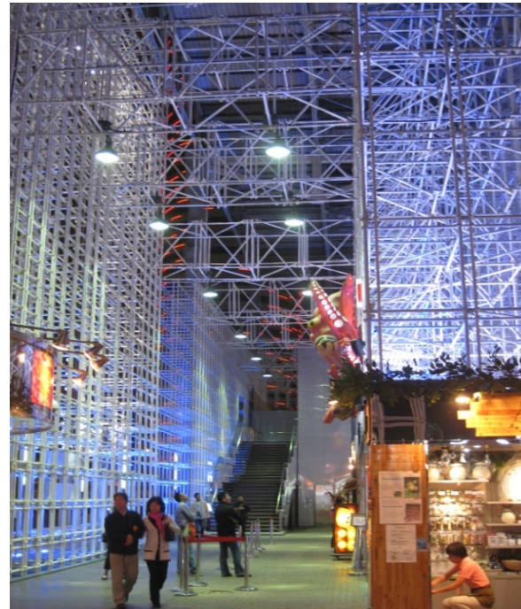
単管格子による広場空間
