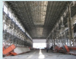
旧硬軟造船所遺構 (内部)
