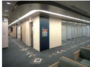
下がり天井とライン照明、床のデザインによる明快的なメイン通路
