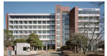
活用事例④: 1号館本部・講義棟 (旧電電公社鈴鹿学園本館)
