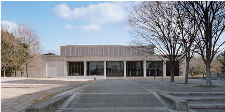
活用事例①: 講堂 (第13回中部建築賞入賞: 旧電電公社鈴鹿学園講堂)
