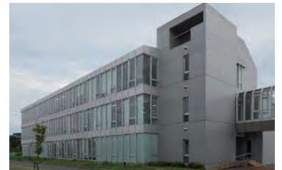
活用事例②: 2号館 (旧第2座学棟)
