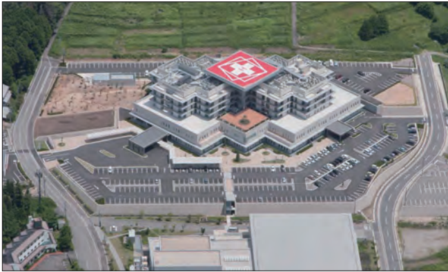
写真 1階:外来,2階:手術、リハビリ、透析、管理、サービス、3-5階:病棟、R階:ヘリポート
