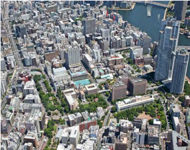
写真1 中央区明石町保有建物の全景
