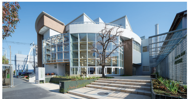
写真3 老朽化した温浴施設をリノベーション【旧すみだ健康ハウス⇒新八広児童館】
