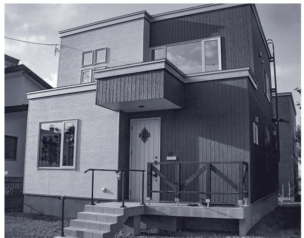
写真2 「北海道R住宅」として改修した後の外観。耐震性、断熱性を向上させた
