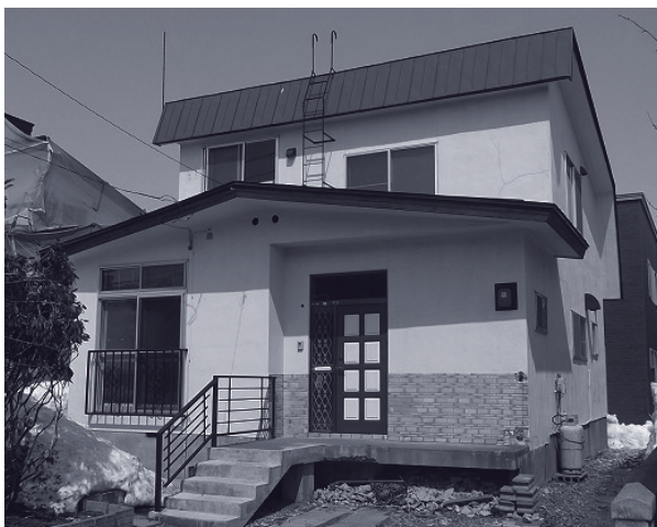
写真1 改修前の住宅外観
