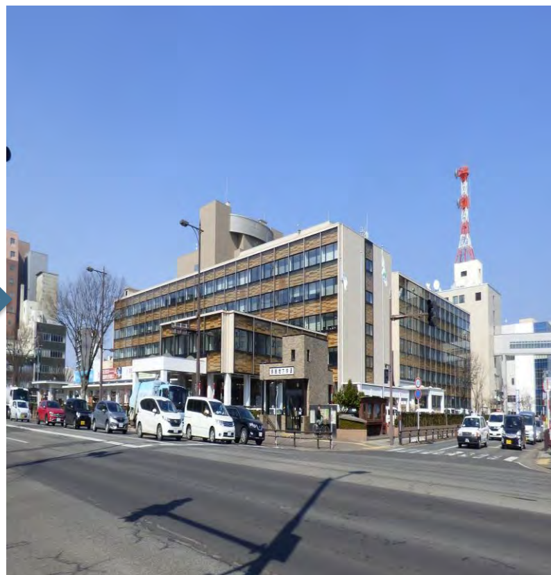
改修後（平成30年）
