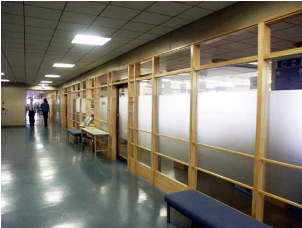
6階エレベーターホール前廊下部（県産材使用）
