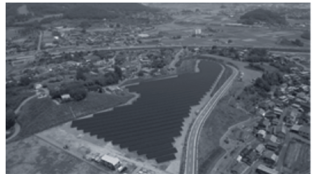
写真1 おおた太陽光発電所
