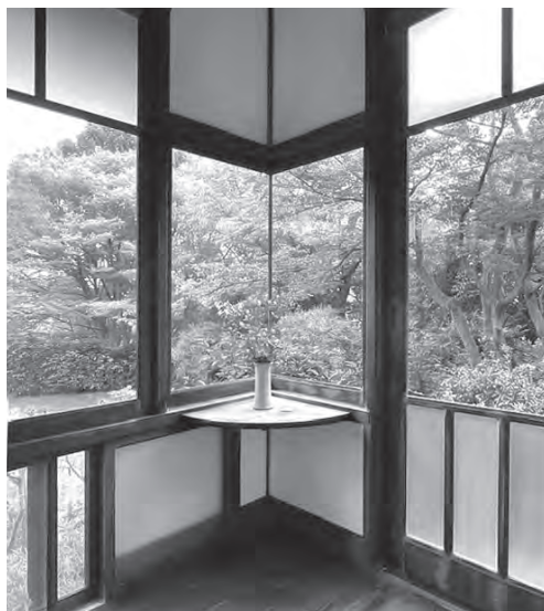
写真1 縁側のコーナー補強材を兼ねた棚
